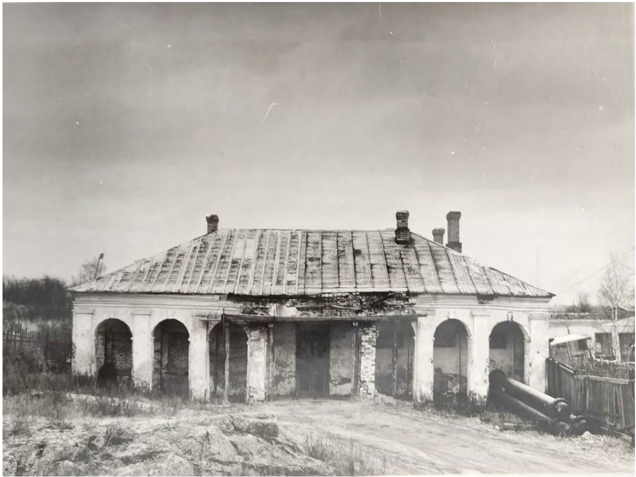
Илл. 31. ЛФИ «Спецпроектреставрация». Вид на главный фасад здания кордегардии с юго-запада 1977 г.
